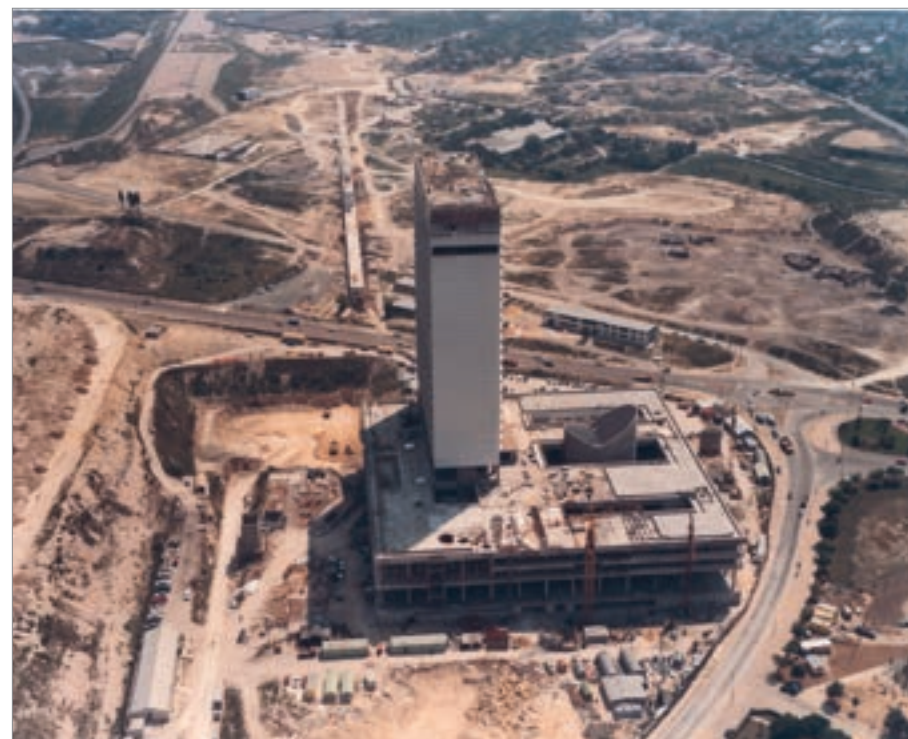
Le chantier de la préfecture des Hauts-de-Seine. 1971. / 36W226
